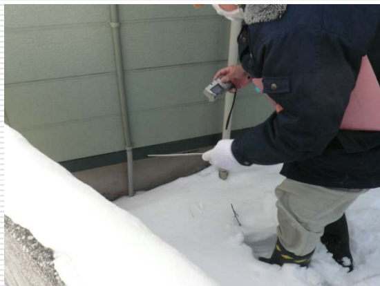
基礎の検査(積雪で基礎が見えづらい)
