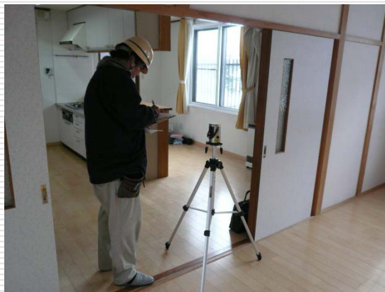
レーザー水準器で傾斜を検査
