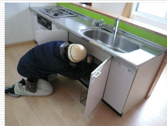
給排水管路の検査
